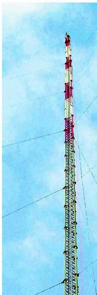
Alle Elemente des 99 Meter hohen Turms zusammengebaut. CS
